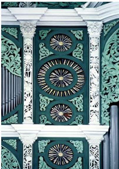
Zur Restaurierung der Sonnenmixture (2004)
